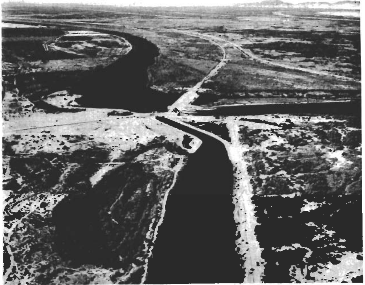
Palo Verde Diversion Dam.
